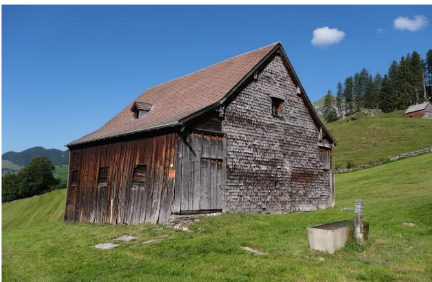
Stall beim Haus in der Rüchi, Wildhaus. Interessante Verschindelung auf der Ostseite, die auch die Pfetten schützt. Privatbesitz.
