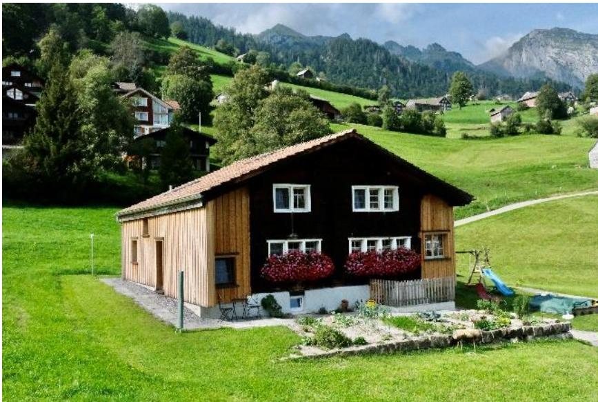
Tätschdachhaus für eine Familie in der Nesselhalden, Unterwasser, aus dem 16. bis 17. Jh. Kürzlich renoviert. Privatbesitz
